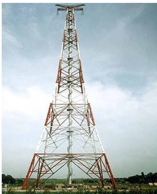
大跨越钢管塔
