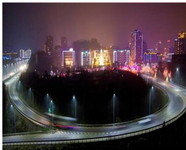
渝武高速公路北碚至北环路段 LED 路灯改造项目
