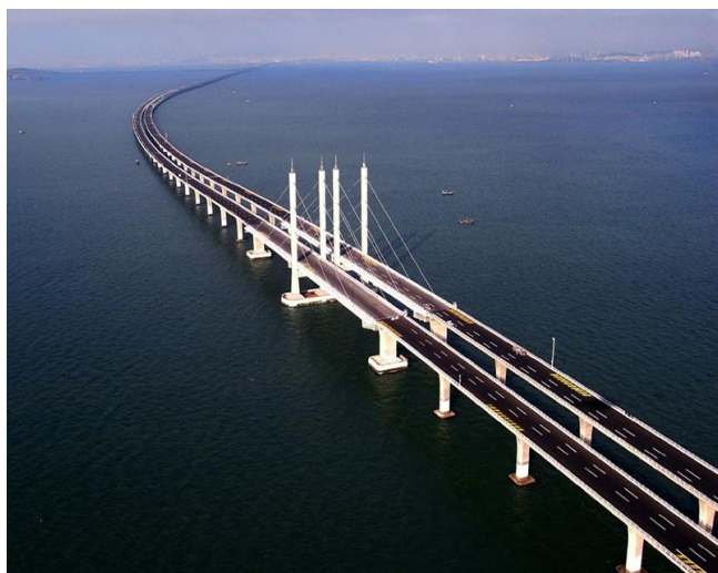
青岛胶州湾大桥 LED 照明系统
