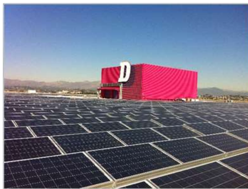
美国 dependable 光伏屋顶电站项目
