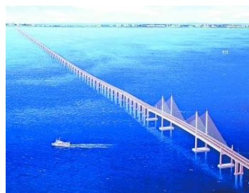
泉州湾跨海大桥
