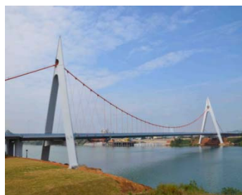
柳州双拥大桥（悬索桥）
