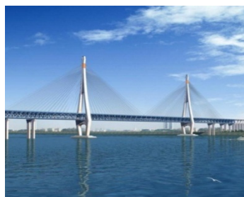
铜陵长江大桥（斜拉索桥）
