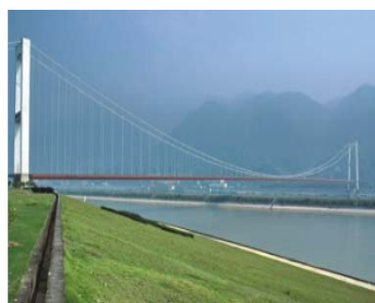
西陵长江大桥（悬索桥）
