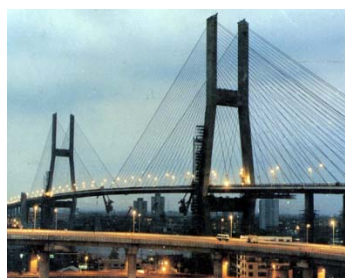
上海南浦大桥（斜拉索桥）
