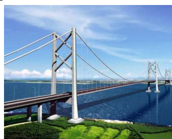
湖北阳逻长江大桥
