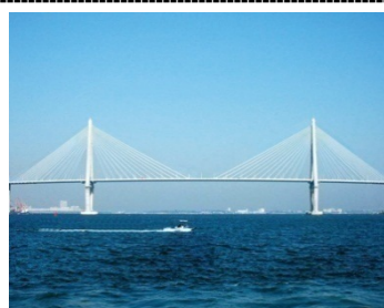
福建厦漳跨海大桥
