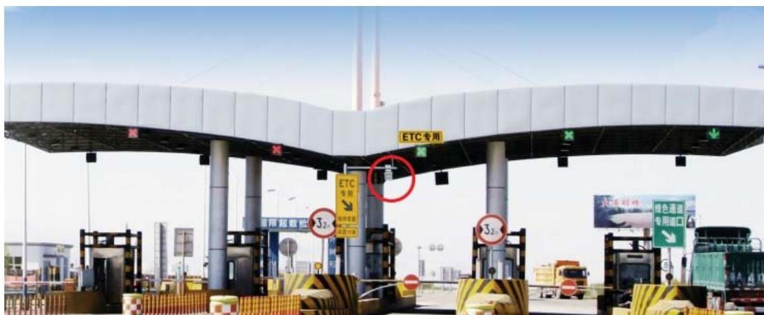
微波天线是安装于高速公路不停车收费车道上，用于发射信号识别来车并与来车的车载单元进行通讯、扣费等。公司的主要微波天线产品有：
