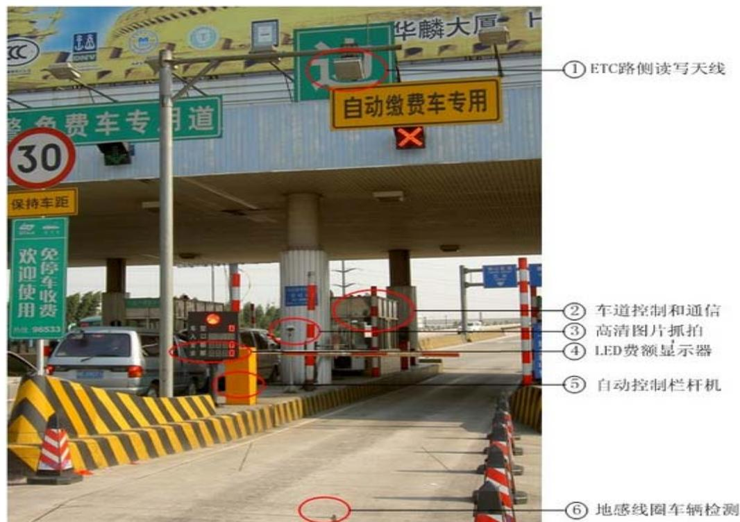
高速公路电子不停车收费系统（即 ETC 系统）是通过安装在车辆挡风玻璃内侧的 OBU 与收费站 ETC 车道上的 RSU 进行专用短程通讯，实现电子自动计费、不停车高效通行的收费系统。
