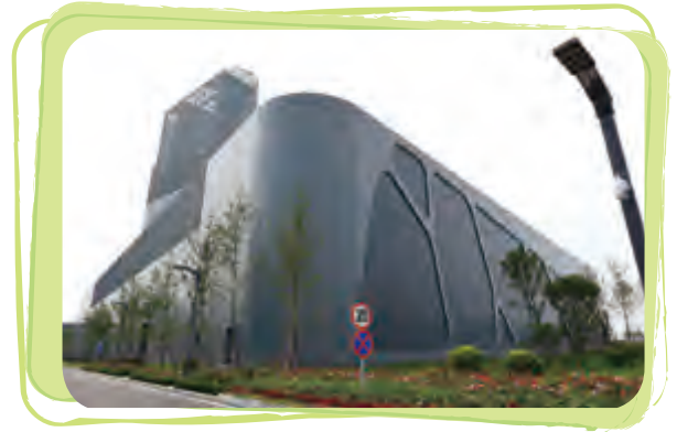
智能电厂 – 神华国华(北京)燃气热电有限公司
