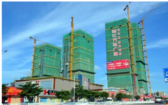
佛山华南金谷工程
