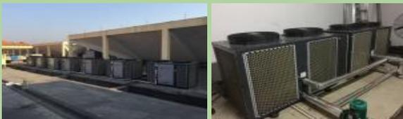
◆2016年，商城集团商城宾馆对酒店三楼空调管网进行联网改造，通过增加风冷机组隔音罩，降低噪声污染，改造风冷螺杆机组管网，降低电能浪费。同时每天对酒店能耗进行统计，加强日常巡查跟进，发现浪费及时督促改进。通过细节管控，商城宾馆能耗比从去年的10.5%下降到8%。
