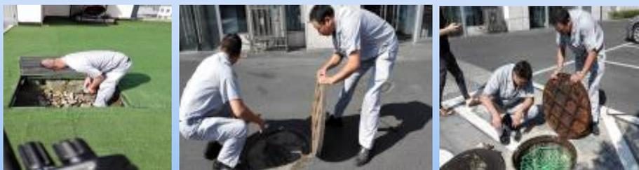
◆幸福湖酒店建立健全五水共治“网格化”管理体系，对酒店辖区内排水实现雨水、污水分流，保证雨水管道、污水管道不会相互混接，雨水排入市政雨水管网，污水废水排入市政污水管网；对酒店区域内所有路面窨井盖都加装了防护网，严格按照规定进行排水系统的清理疏通；开展常态化巡查，定期开展排水管网检查，摸清排污口底数，标出辖区内雨污水排放管网示意图；做好辖区内防洪水、排涝水工作，汛期进行防台防汛安全检查，设立专柜放置抗洪沙包，定点放置抗洪排涝专用的潜水泵及其水带，有力保障防台防汛应急处置措施；健全幸福湖水库周边保洁制度，定期开展清检河道垃圾活动；请专业污水检测机构每季度对生活污水口进行提样检测，并出具检测报告，全年发生费用0.5万元；对部分下沉管网进行开挖、清理、疏通，全年发生费用1万元；对酒店化粪池、污水管进行全面疏通，全年发生费用约3.5万元，全年共计投入五水共治治理费用约5万元。
