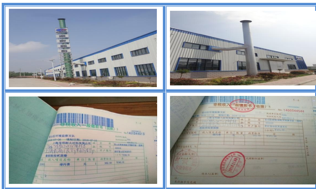
图 5-2 排污口规范化及分厂区交纳排污费情况
