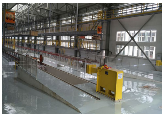
库修车间地坪涂料
