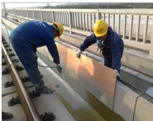
高铁混凝土桥梁聚氨酯防水涂料
