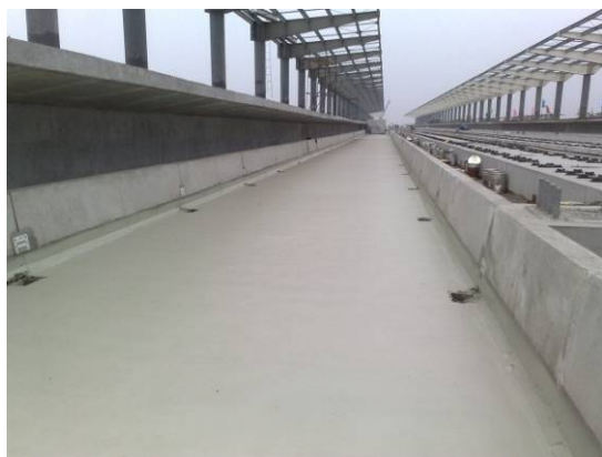
高铁混凝土桥梁聚脲防水涂料
