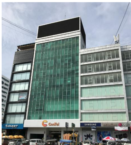
柬埔寨信威办公楼
