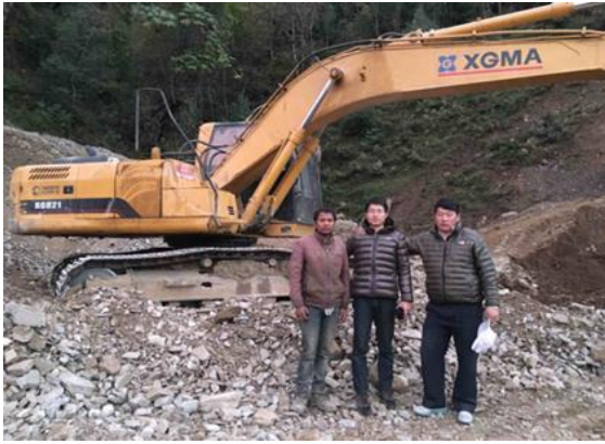
不丹山间公路建设维护
