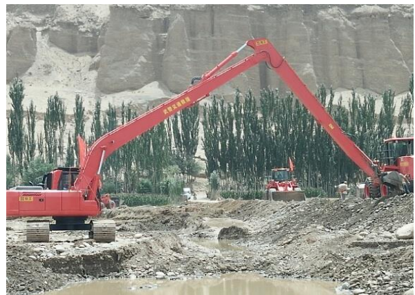
厦工“武警红”奋战抢险第一线
