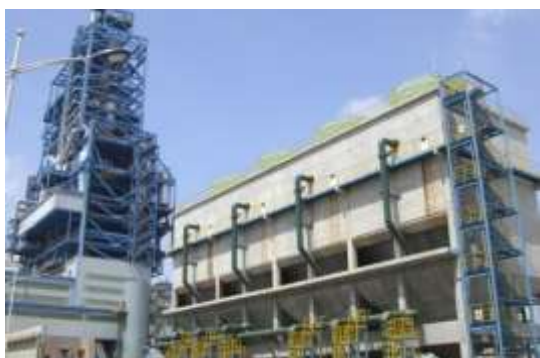
宝钢集团上海浦钢 COREX 炼铁项目（上海） 4 台 NHZK-1275 型冷却塔
