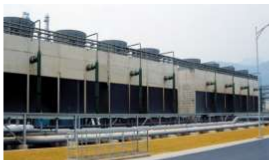
中海壳牌石油化工有限公司南海石化项目 (广东·惠州)
