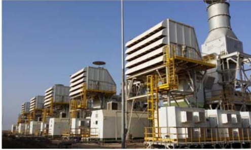
➤ 七〇三所 UGT15000 型号燃气轮机发电机组配套消声过滤装备（乌克兰曙光燃气轮机）。
