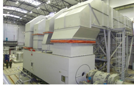
➤ 七〇三所 UGT25000 型号燃气轮机发电、压气机组配套消声过滤装备（七〇三所燃气轮机）。
