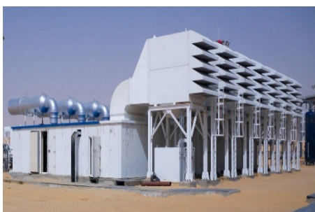
➤ CLYJ-D1200 柴油发电机组自清式消声过滤装备。
