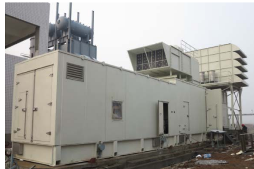
➤ 12800KW 燃气轮机配套产品，应用于发电。
