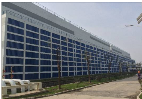
➤ 华电重工热电厂项目配套消声装备。
