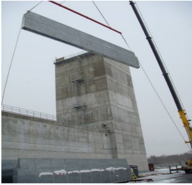
➤ 加拿大蒙特利尔机场航空发动机试车台消声过滤配套装备。
