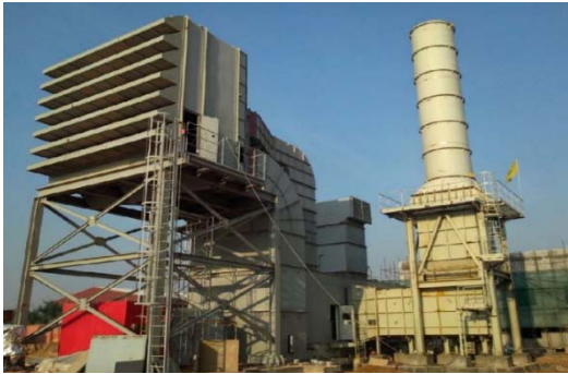
➤ 12800KW 燃气轮机配套产品，应用于油田。
