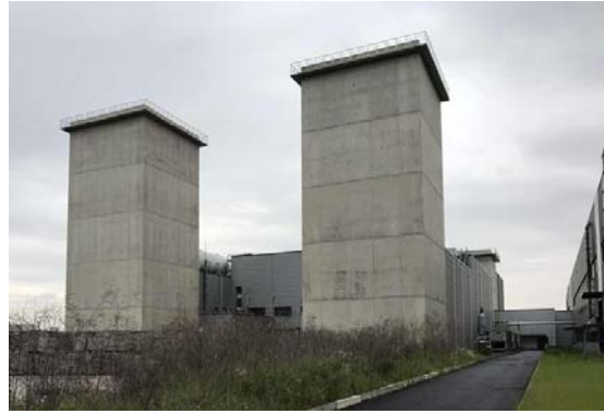
➤ 中航商发航空发动机试车台消声过滤配套装备。
