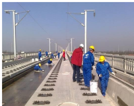
高铁混凝土桥梁基层处理底涂
