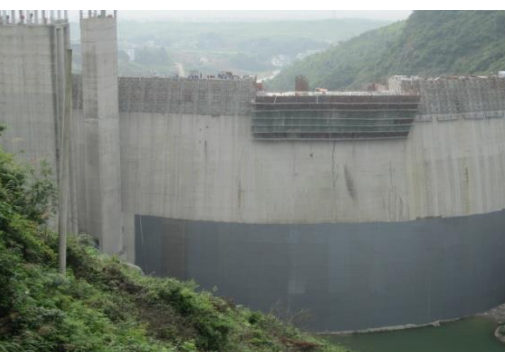
水坝工程防水
