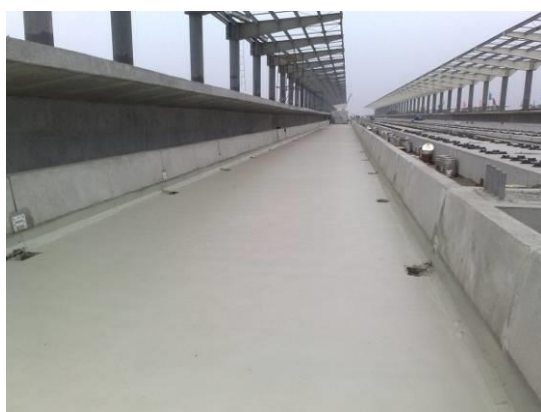
高铁混凝土桥梁聚脲防水涂料
