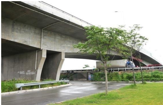
香楠路跨沪宁高速公路桥
