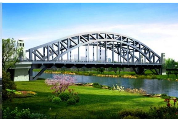
安泰路直湖港大桥
