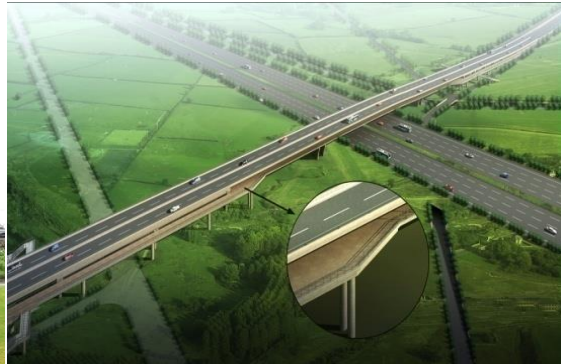
飞凤路上跨沪宁高速公路桥
