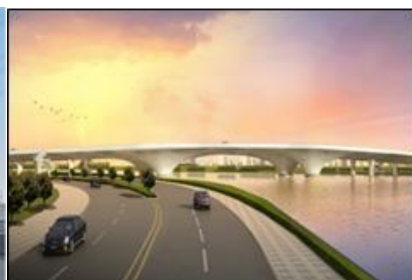
马鞍山路北环城河大桥
