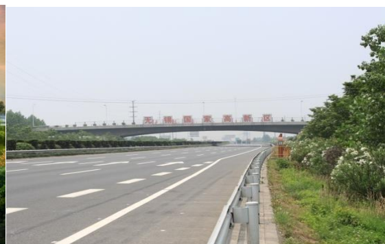
新华路跨沪宁高速公路桥
