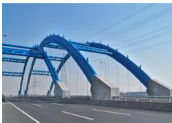
342 省道直湖港大桥
