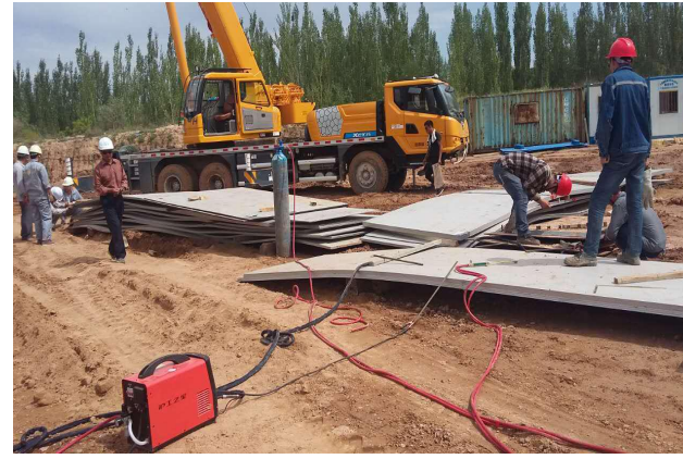
安装单位储罐制作安装（8月6日）
