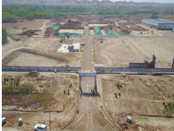
土建施工进行中（5月11日）
