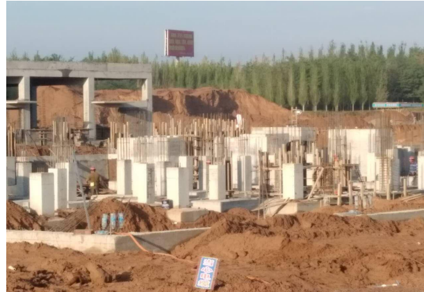
炭肥车间施进行中（7月25日）
