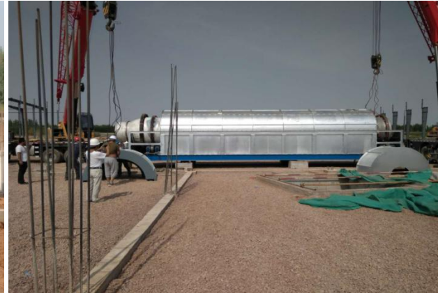
安装炭化炉主体（7月20日）
