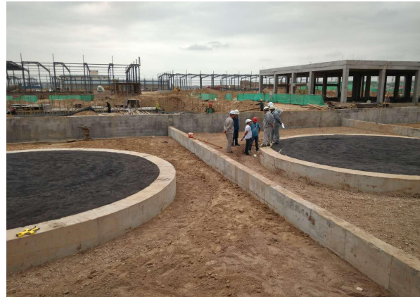
木醋液储罐基础完成（8月1日）
