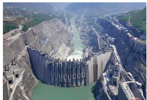
四川溪洛渡水电站
