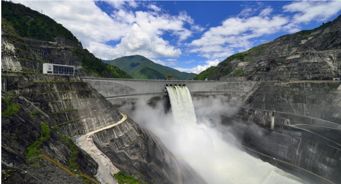
图6.4：坝式水电站示例-小湾水电站
