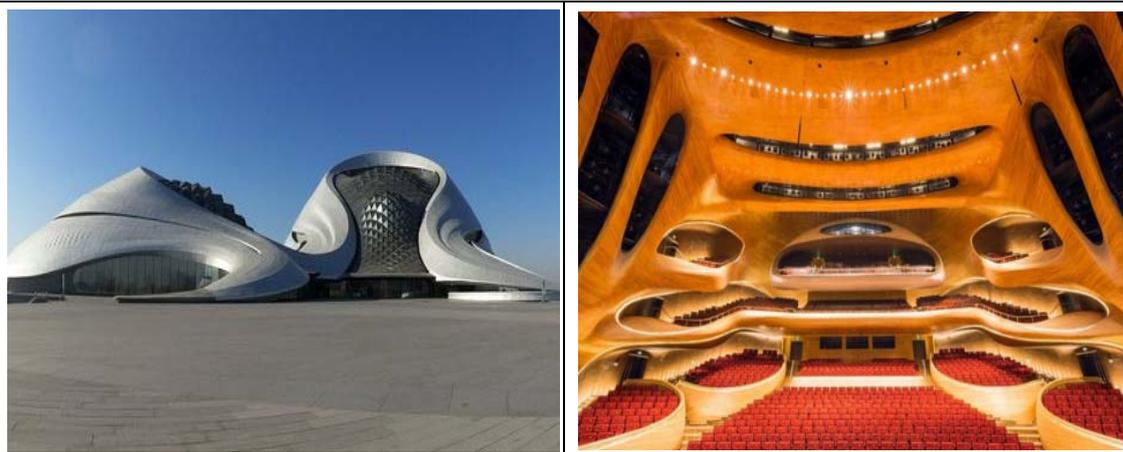
为满足自然声需要，哈尔滨大剧院原本设计为全实木，但该设计无法满足消防要求。为满足自然声、双曲面艺术效果和消防的需求，公司在充分评估、实验后使用 GRC 作基底材料，再在其表面黏贴装饰木条，观众厅总计粘结 20 多万根水曲柳木条，长度达 190 公里，全部由纯手工粘贴，再打磨表面，最终呈现出双曲面实木的纹理和色彩，工艺极为复杂。同时，公司统筹了双曲面的二次结构转换、装饰与建筑声学、材料、机电、音响、灯光及舞台的工程集成。哈尔滨大剧院荣获中国土木工程詹天佑奖、中国建筑工程鲁班奖及中国建筑工程装饰奖。
