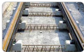
轨枕钢筋骨架
