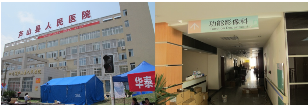
芦山县人民医院震后主体完好、功能迅速恢复
