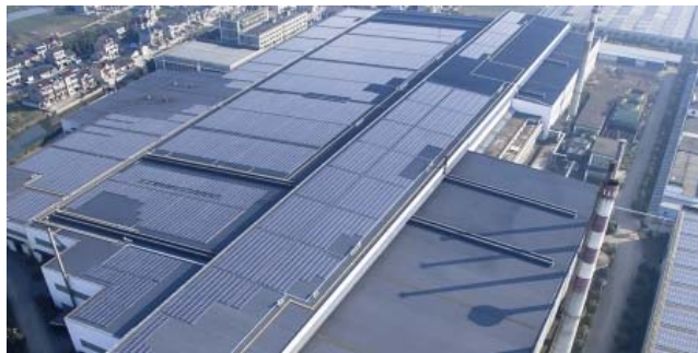
格洛斯（老厂）5055.12KWp 分布式光伏电站
