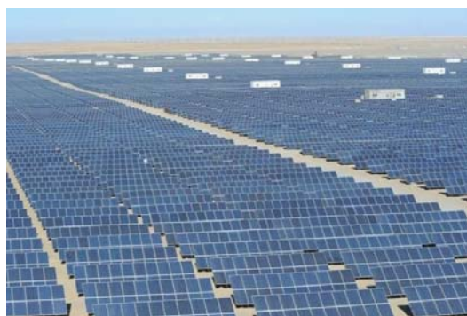
集中式光伏电站
