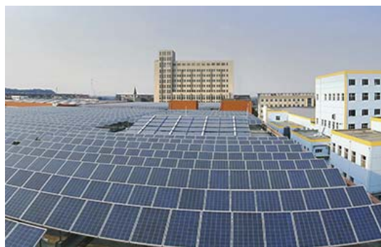
屋顶分布式光伏电站
