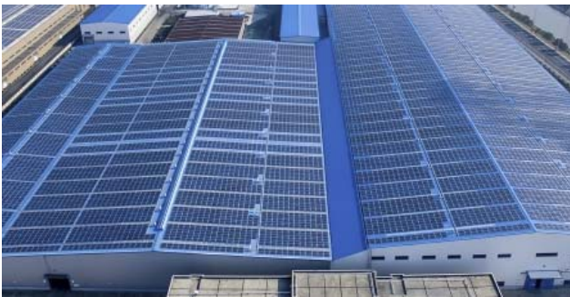
旗滨玻璃 6046.56KWp 分布式光伏电站
