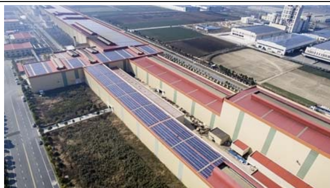
联鑫板材 5,318.5KWp 分布式光伏电站
