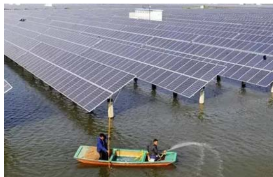
渔光互补光伏电站
