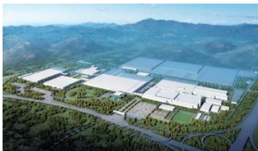
北京现代全厂项目
