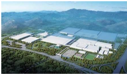
北京现代全厂项目
