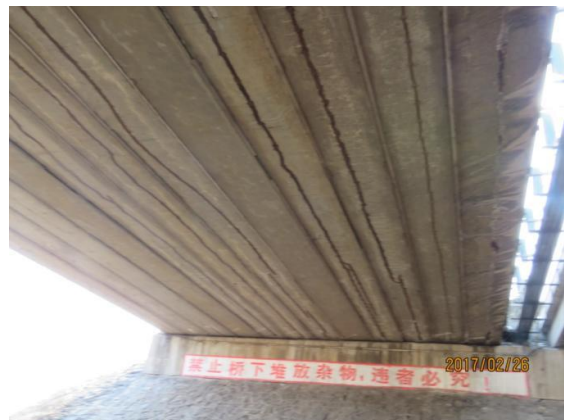
图 4-7-3 韩庄公铁立交上部封闭裂缝
