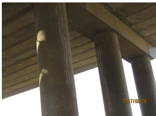
图 4-6-9 桥墩竖向裂缝
