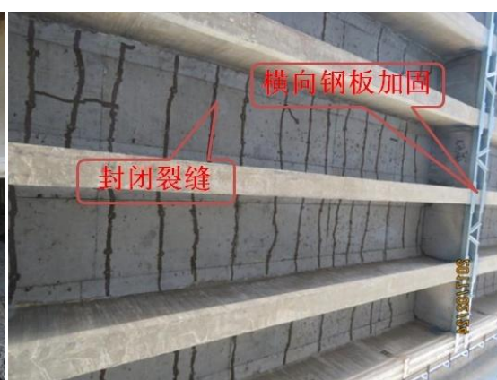
图 6-5-28 横隔板钢板加固
