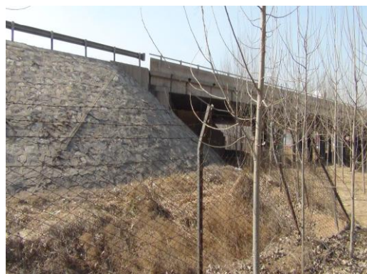
图 4-5-5 桥头浆砌片石防护
