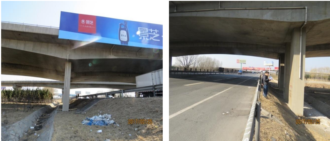
图 6-5-35 上跨京台高速桥下净空现状图
