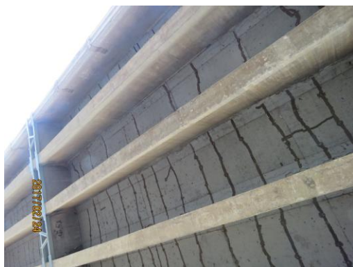
图 4-6-5 T 梁翼缘横向裂缝
