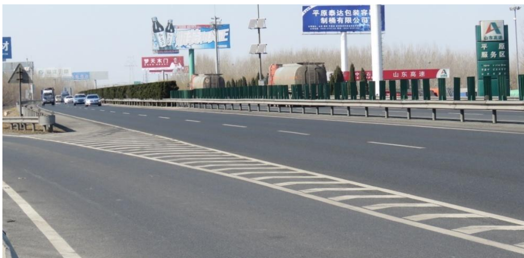
图 6-5-16 中央分隔带护栏现状
