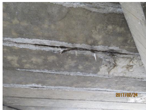
图 4-6-4 板底铰缝脱落渗水
