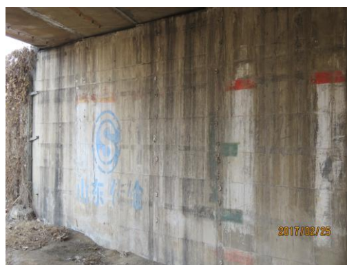
图 4-6-8 桥台竖向贯穿裂缝
