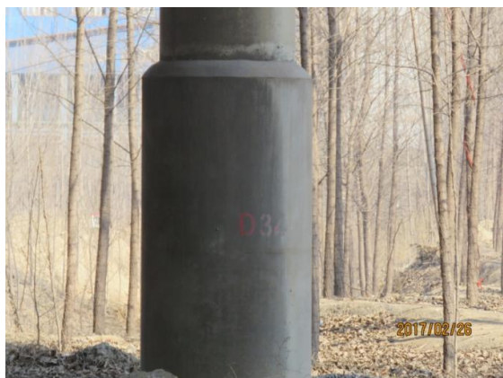
图 4-7-4 韩庄公铁立交下部加固墩柱
