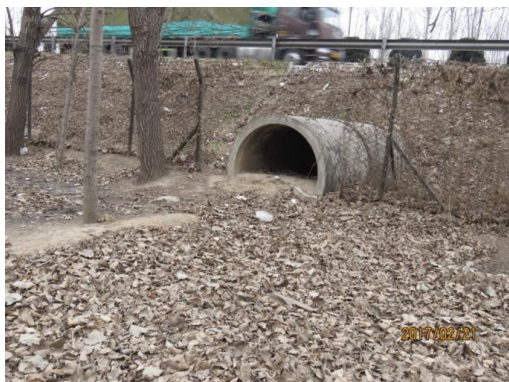
图 4-6-12 圆管涵洞口淤塞
