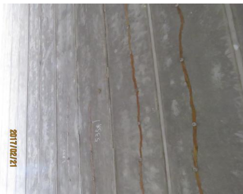
图 4-6-3 板底纵向裂缝
