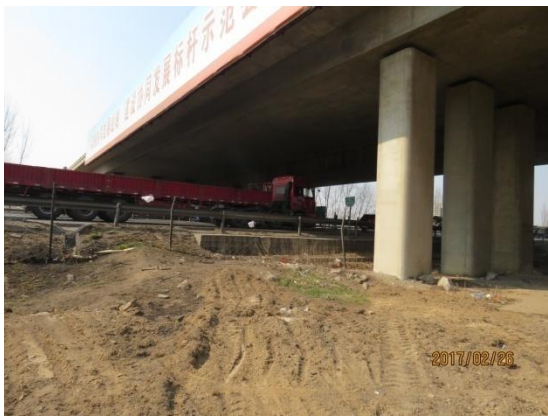
图 6-2-5 晏城枢纽立交现状图 1
