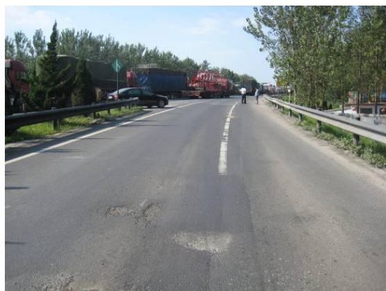
图 4-5-12 匝道坑槽
