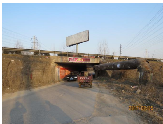
图 4-7-13 通道现状净宽不足
