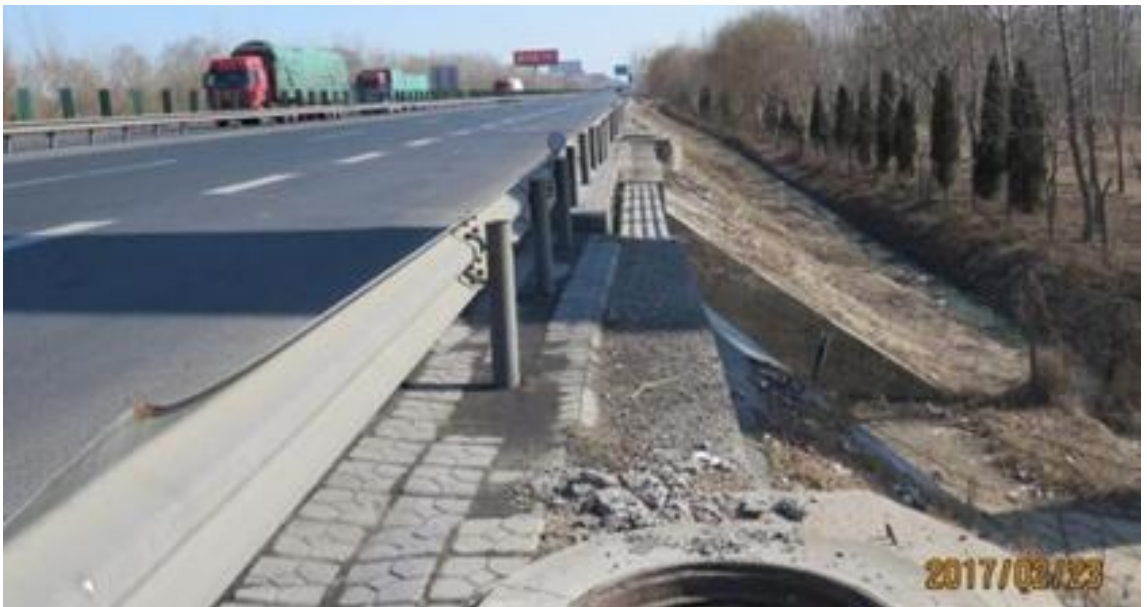
图 6-5-14 管线改移至右侧
