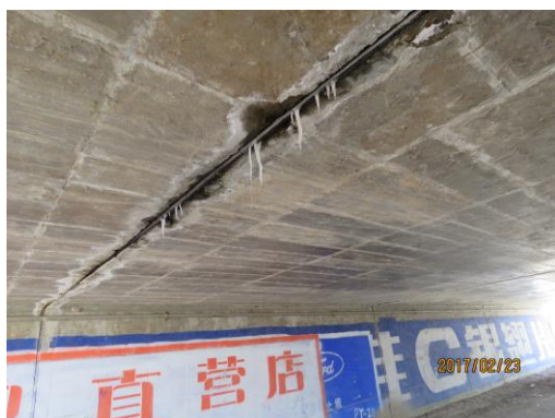
图 4-6-14 箱涵沉降缝渗水
