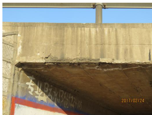
图 4-6-15 涵顶混凝土锈胀脱落
