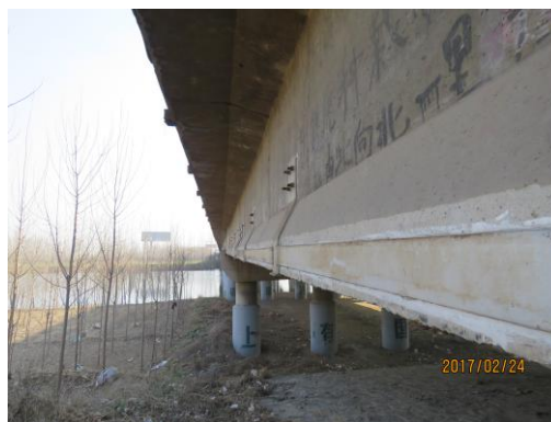
图 4-6-6 T 梁马蹄钢板加固
