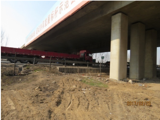
图 1-8 晏城枢纽立交现状图 1
