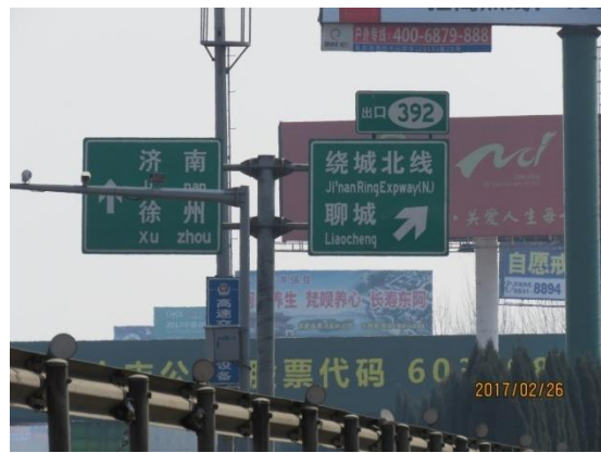
图 6-2-6 晏城枢纽立交现状图 2
