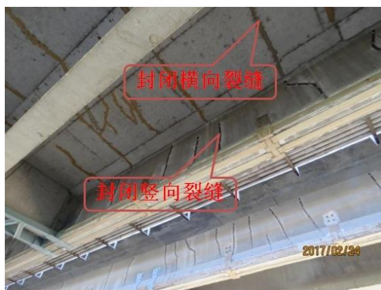
图 6-5-29 T 梁翼缘和现浇段横、竖向裂缝
