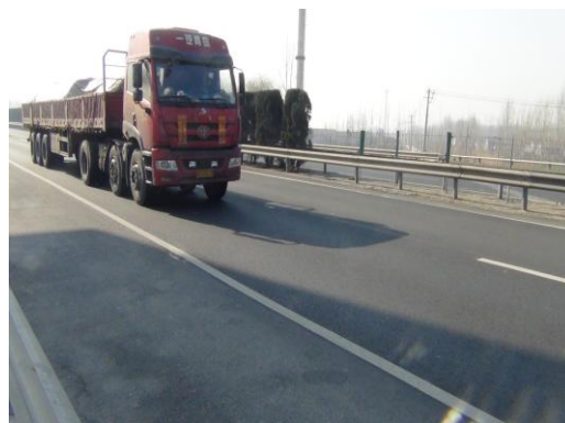
图 4-5-9 中央分隔带铺砌破坏
