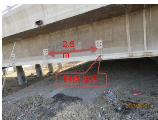
图 6-5-27 边梁马蹄钢板加固
