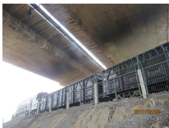
图 4-7-7 韩庄公铁立交跨铁路现状图 2
