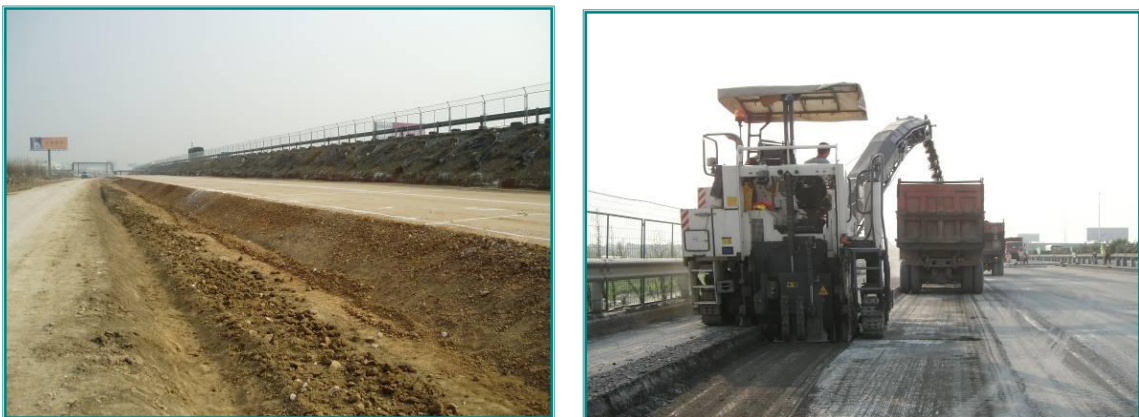
图 6-4-5 扩建中的沪宁高速公路
