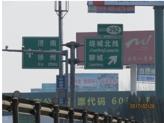
图 1-9 晏城枢纽立交现状图 2
