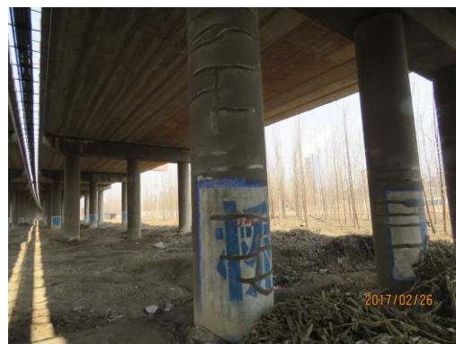
图 4-6-10 桥墩环状裂缝
