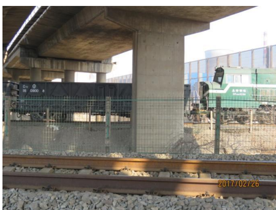
图 4-7-6 韩庄公铁立交跨铁路现状图 1
