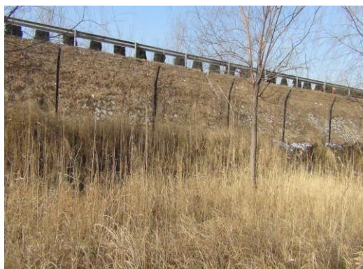
图 4-5-4 浆砌片石防护
