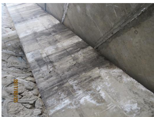
图 4-6-7 下部构造混凝土破损
