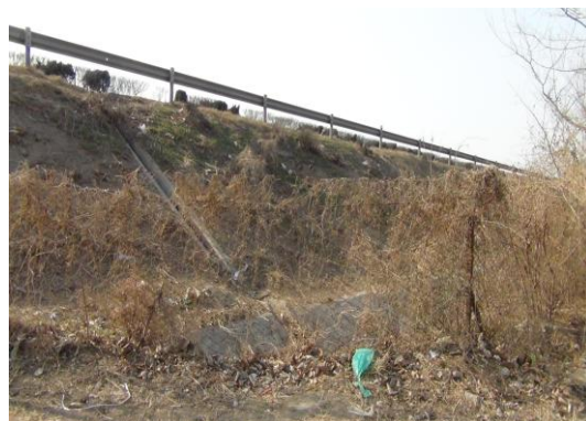
图 4-5-7 集中排水急流槽
