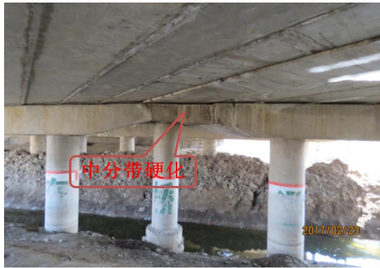
图 6-5-13 桥梁中分带硬化现状图
