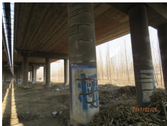
图 4-7-5 韩庄公铁立交下部封闭裂缝
