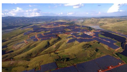
云南建水 300 兆瓦电站
