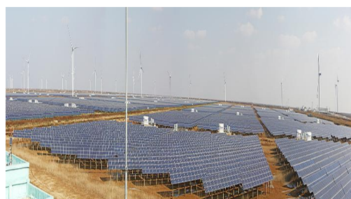
江苏响水 120 兆瓦渔光互补电站
