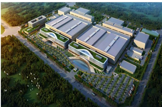
福建晋华存储器集成电路厂房外墙板项目
