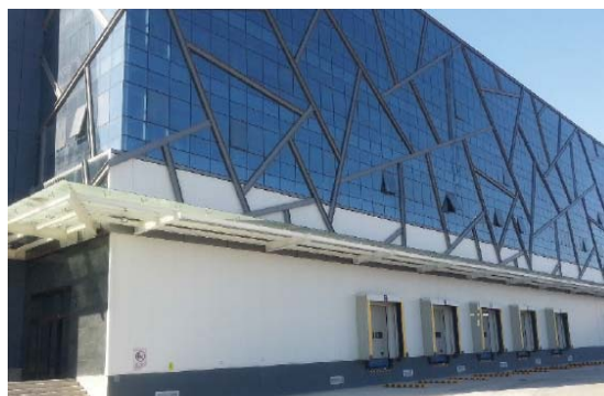
北京京津港国际物流有限公司立体冷库项目
