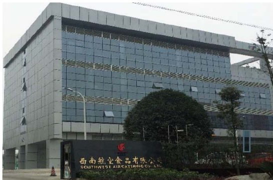
西南航空配餐楼冷库项目
