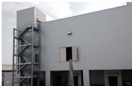
苏州长谷川厂房围护项目
