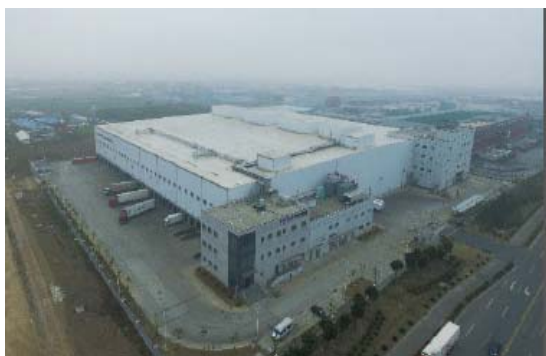
太古冷链物流（上海）冷库门项目
