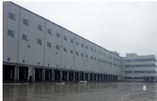
太古冷链物流（廊坊）冷库项目
