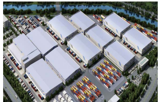
中铁铁龙大连冷链物流项目
