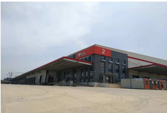
京东武汉新洲物流园项目
