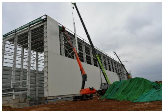
滇虹药业厂房外墙板项目
