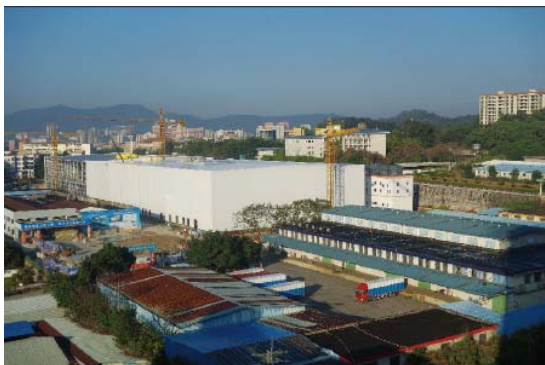
广州长运仓储冷库项目
