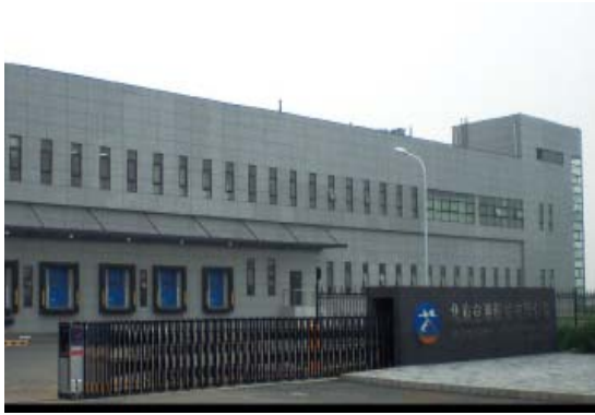
北京空港配餐楼冷库项目
