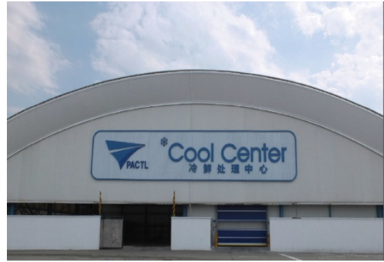
浦东机场冷鲜处理中心冷库项目
