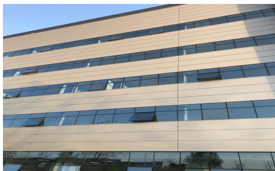
成都京东方光电技术测试中心外墙板项目
