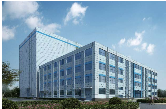
博瑞电力厂房外墙板项目
