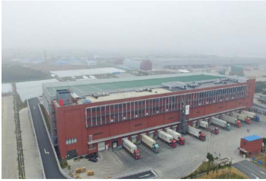
上海千隆物流有限公司冷库项目
