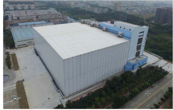
深圳华美冷链物流中心冷库项目
