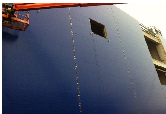
宜家家居（北京大兴）外墙板项目
