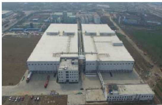
太古冷链物流（南京）冷库项目
