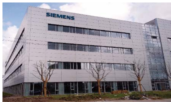
上海西门子厂房围护项目
