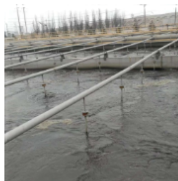
生化处理好氧池
