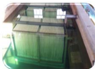
一期预处理运行中高强度膜池
