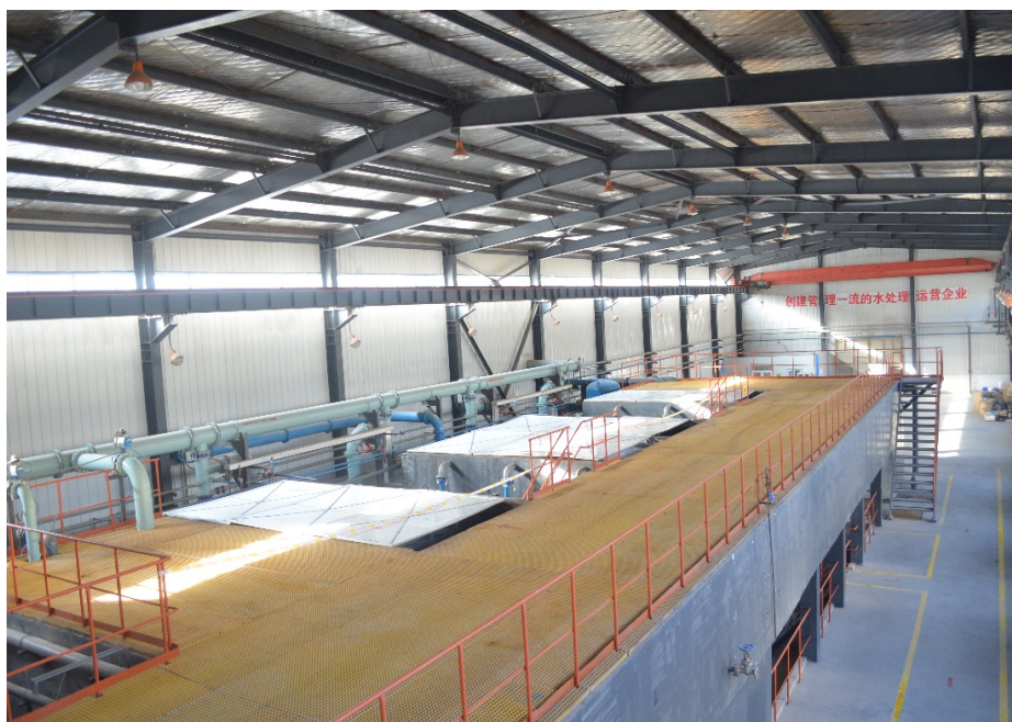
原平倍杰特国家电投山西铝业中水回用项目+给水预处理项目
