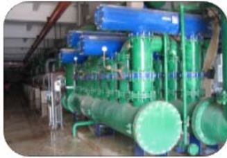
自清洗过滤器
