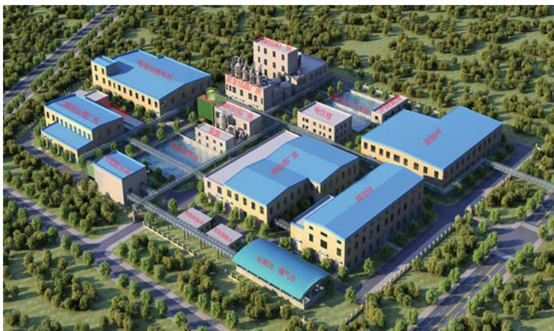
中煤远兴鄂尔多斯纳林河工业园区综合水处理工程
