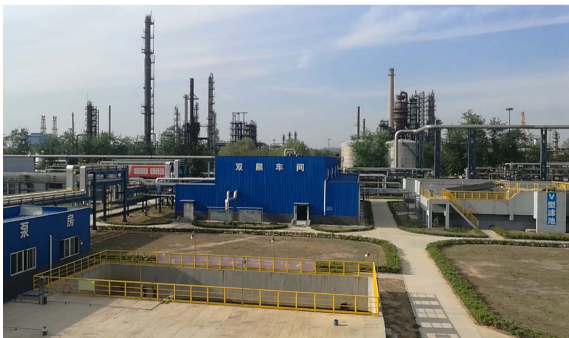
石家庄炼化分公司油品质量升级及原油劣质化改造工程中水回用装置 EP 承包项目
