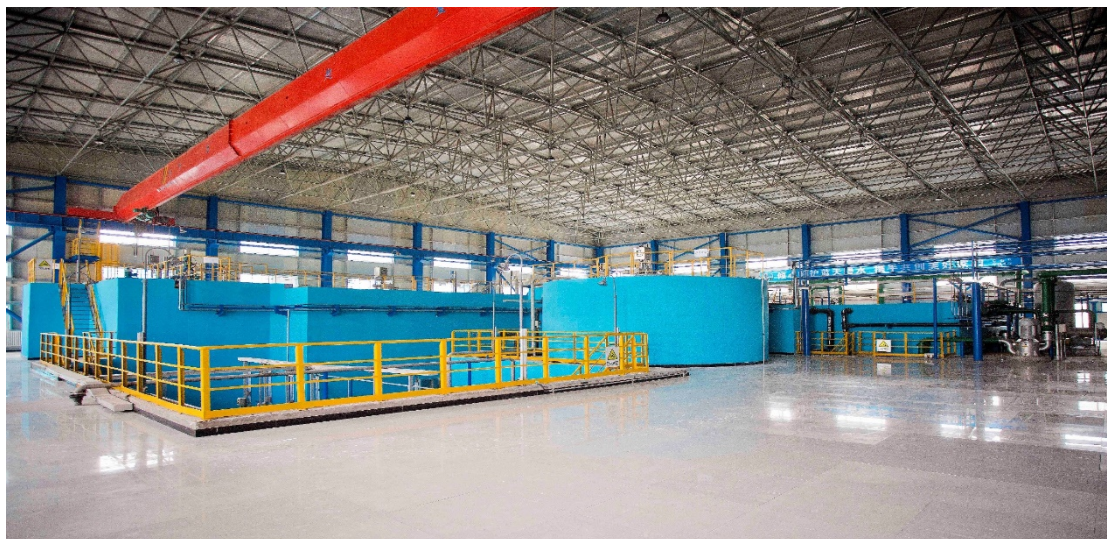
中国石化长城能源化工（宁夏）有限公司高盐水零排放减量化项目
