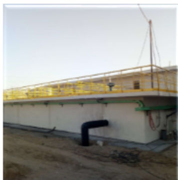
新增V型滤池
