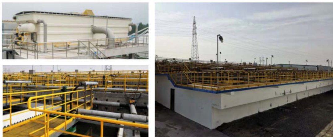
乌海市乌达经济开发区污水处理厂提标改造项目 EPC 总承包项目
