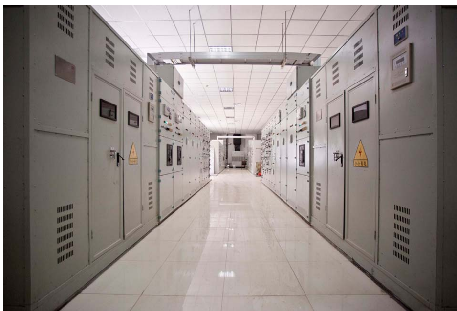
中天运营项目低压配电室
