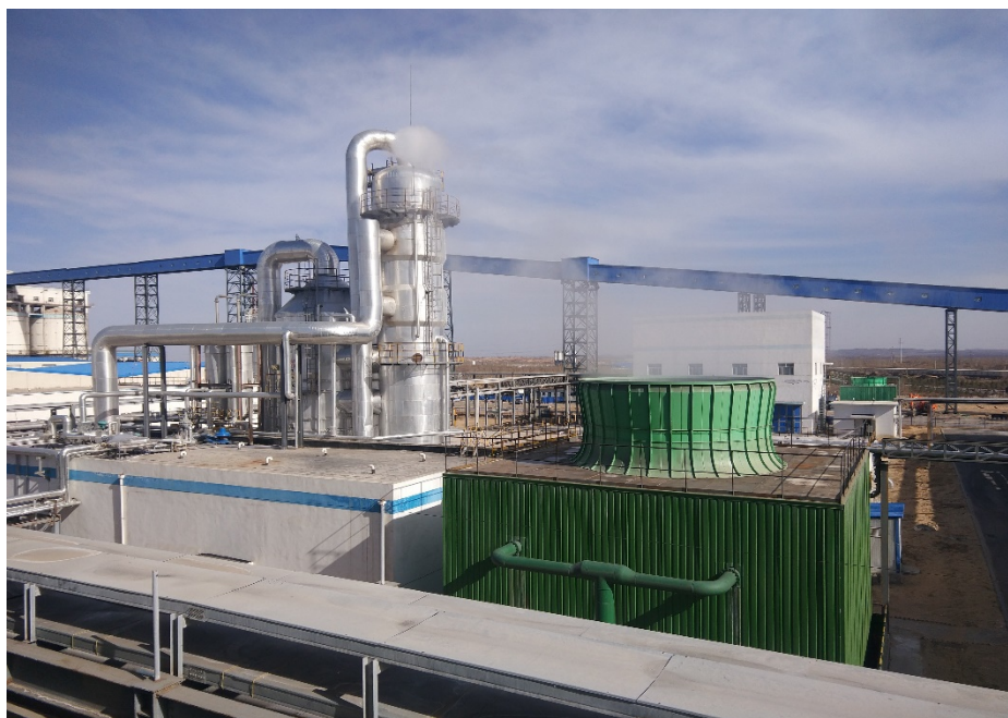
内蒙古中煤远兴能源化工有限公司综合水处理装置托管运营项目
