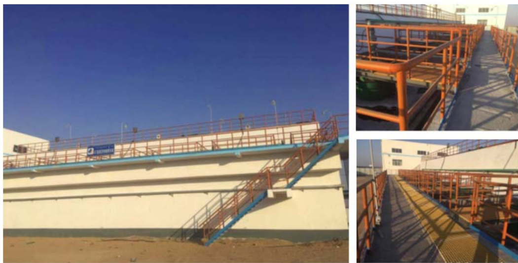
五原县隆兴昌镇再生水厂
