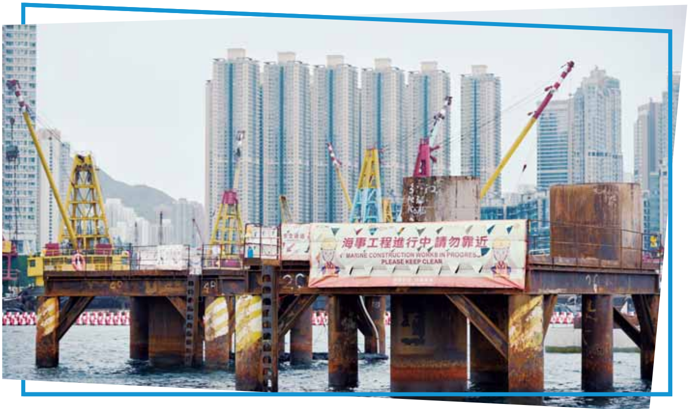
Tseung Kwan O — Lam Tin Tunnel — Tseung Kwan O Interchange and Associated Works 將軍澳 — 藍田隧道 — 將軍澳交匯處及相關工程
