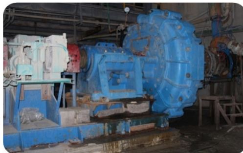
550NZJA 渣浆泵在伊春鹿鸣使用
