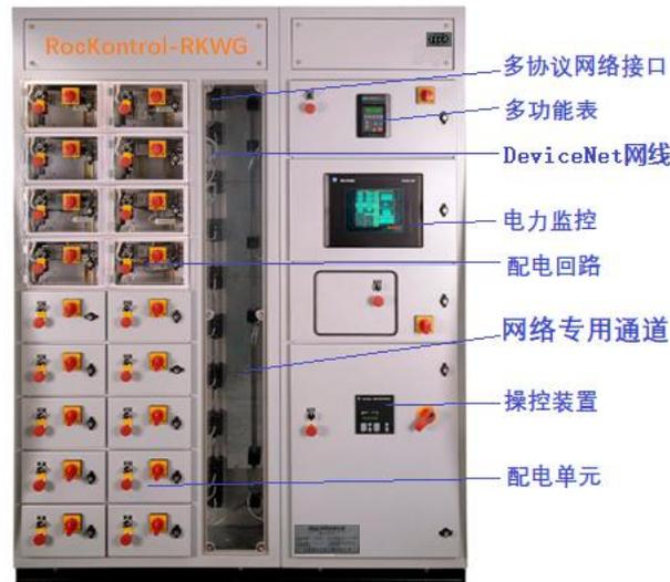
智能配电设备可以被视为一个物联网终端感知设备，其智能化主要体现在可编程逻辑控制器（PLC，Programmable Logic Controller）等方面，在实现智能终端功能过程中需要软件编程，培育了信息化和自动化能力。2007年发行人承担了国家科技部火炬计划——基于三层网络架构的开放式数字配电平台专项。
