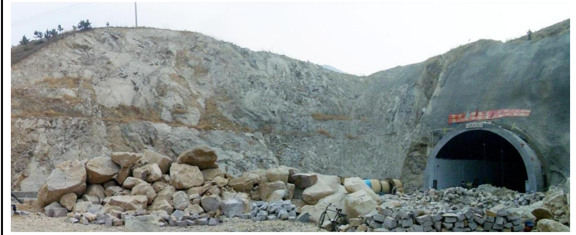
硬质岩石边坡（山东青岛，微风化、裂隙不发育裸岩边坡）
