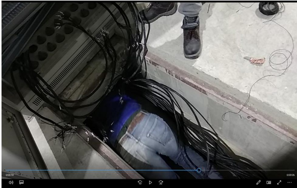
(↑公司技术人员铺设控制电缆)
