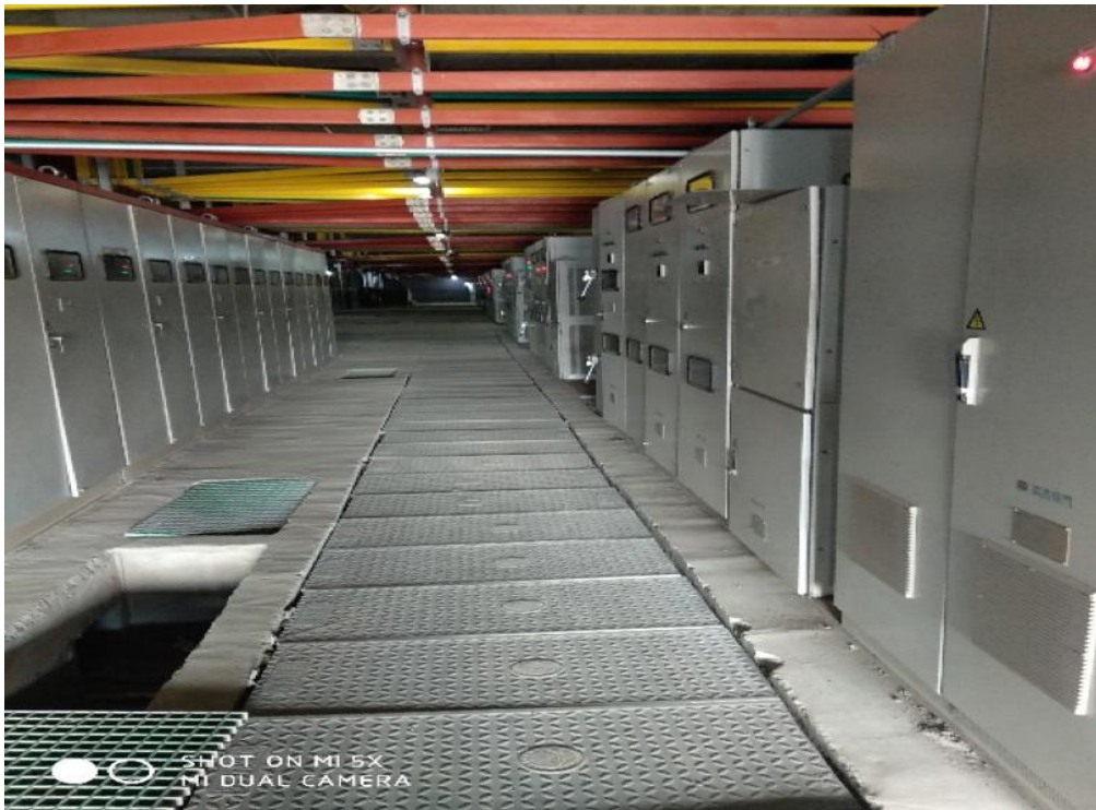
(↑ 公司指导电源设备柜体就位后，客户自行铺设动力电缆，此阶段厂房尚未封闭)
