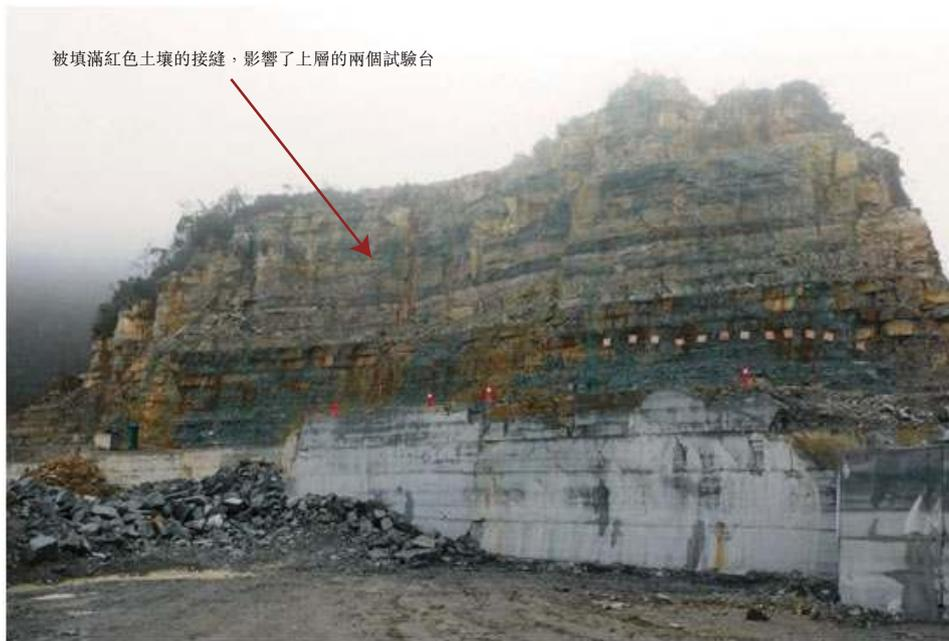
圖4-7：中型喀斯特地貌，一個填滿土壤的開放式縫隙，2號礦區最頂層的試驗台
