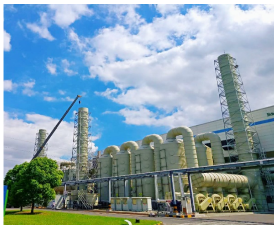
（扬州协鑫光伏项目）
