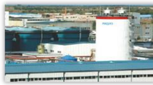
废水处理设施
