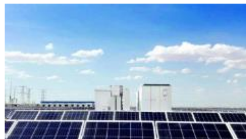
新能源电源管控设备
