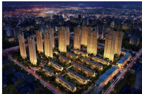
路劲地产城市印象三期配电工程
