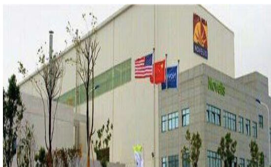
诺贝丽斯（中国）35/20kV 变电站工程
