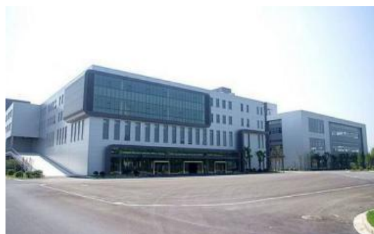
车和进标准厂房 10kV 变电所工程
