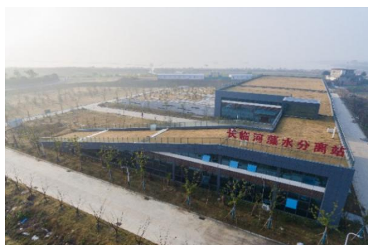
合肥长临河藻水分离站 处理能力：藻浆 5,000m 3 /d
