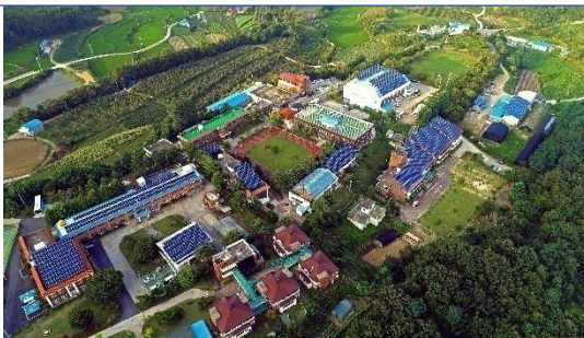
韩国 Andong500kW 项目
