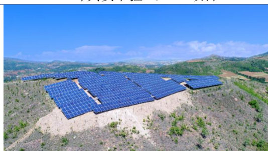
中国河南洛阳 25MW 项目
