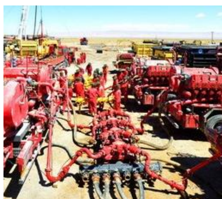
油田压裂系统装置
