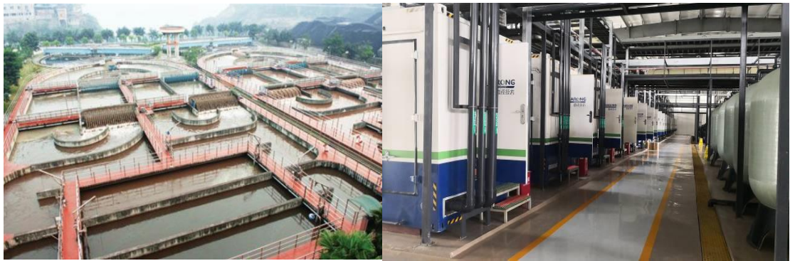
传统工程式废水处理项目
