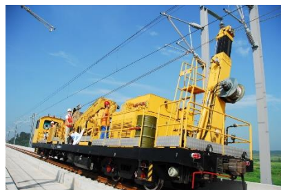
接触网作业车—接触网放线车（恒张力）FX-5
