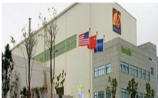
诺贝丽斯（中国）35/20kV 变电站工程
