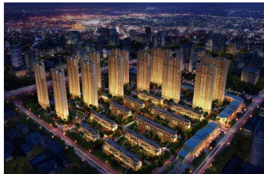
路劲地产城市印象三期配电工程
