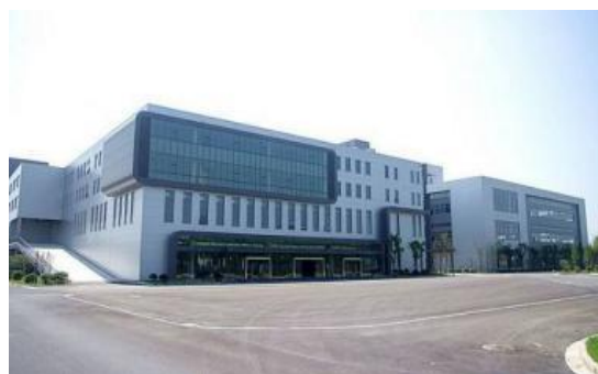
车和进标准厂房 10kV 变电所工程
