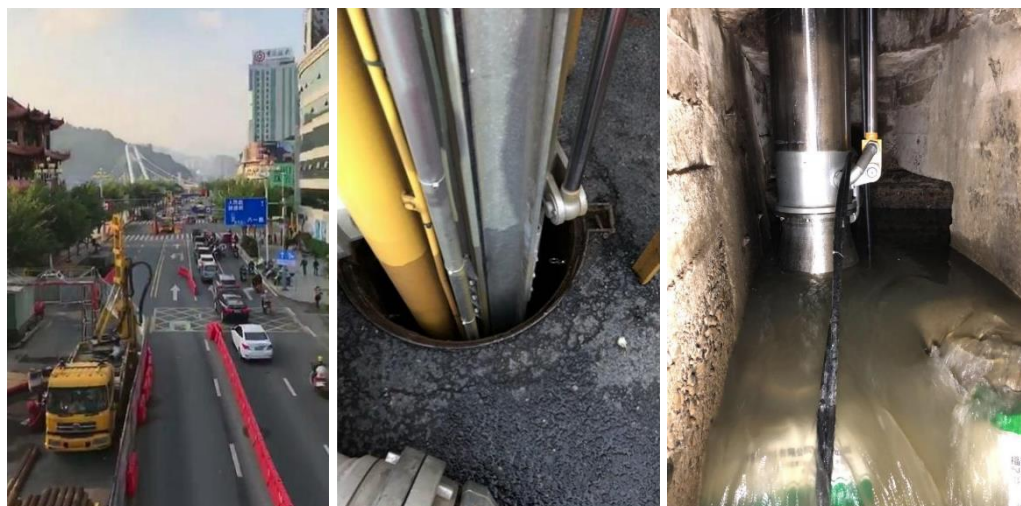
垂直式大流量排水抢险车入井进行大流量抽排便于施工人员抢修
