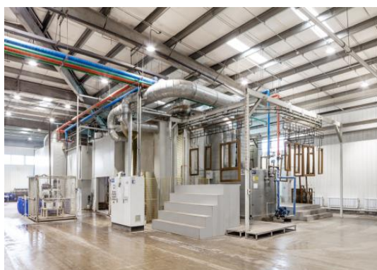
悬挂式自动喷涂线
