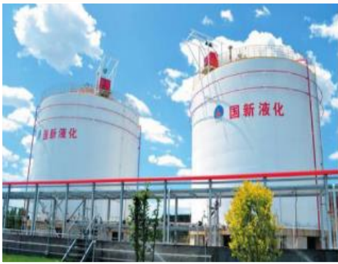
新疆广汇-启东 LNG
