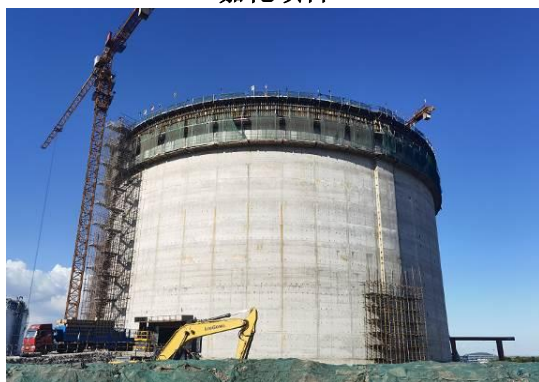
越南 HaiLinh Vung Tau LNG 储罐项目
