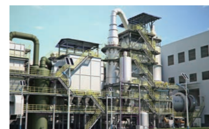
海南某危险废物处置中心 Hazardous Waste Incineration Plant, Hainan
