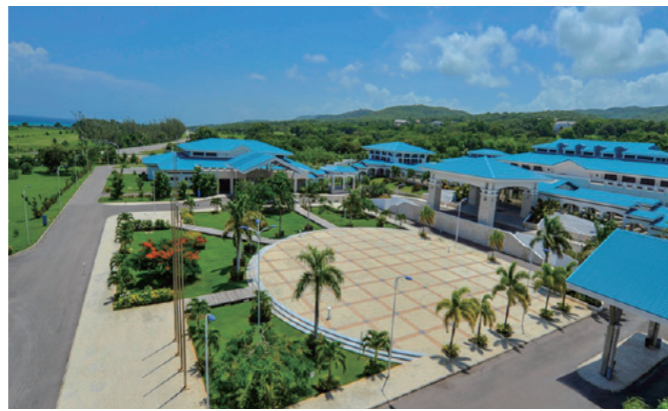
牙买加蒙特哥贝会展中心项目 The Montego Bay Convention Center Project in Jamaica
