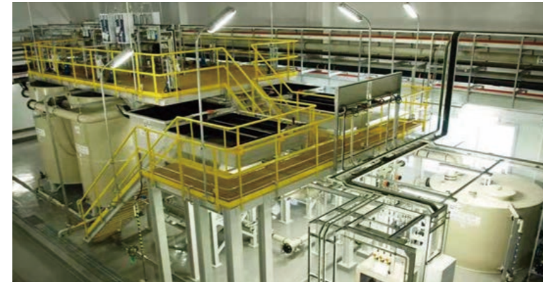
新加坡某废水处理项目 Waste Water Treatment Project in Singapore
