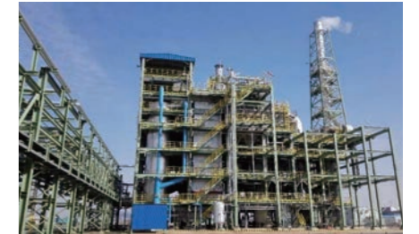
上海某化工行业废液焚烧项目 Liquid Waste Incineration System, Chemical Industry, Shanghai
