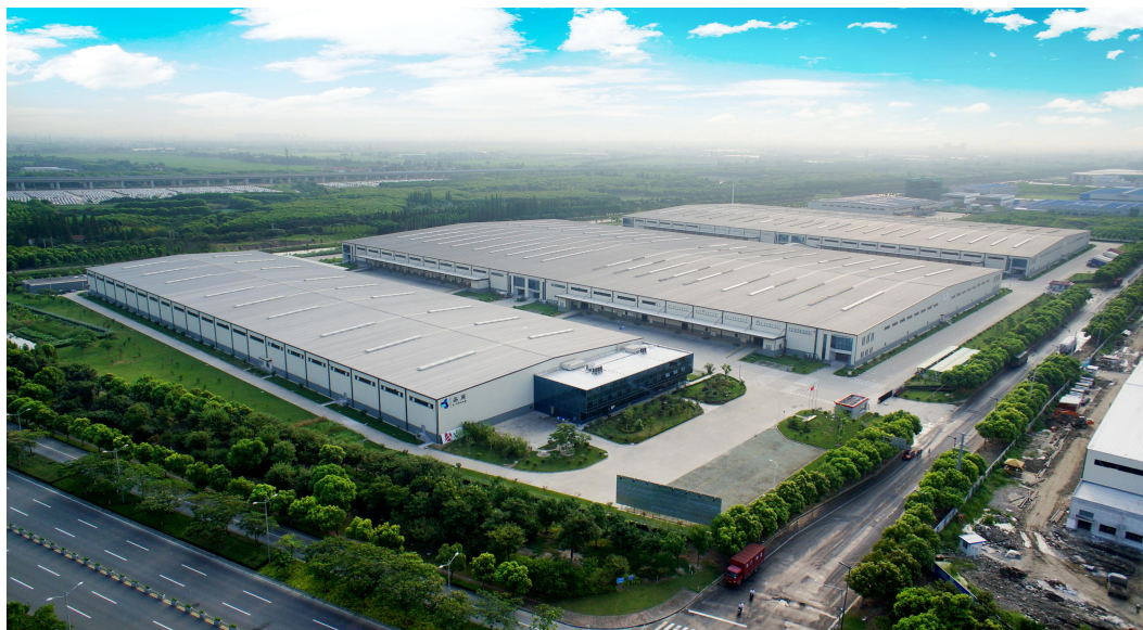
图 14-2 富莱德昆山物流园一期实景图
